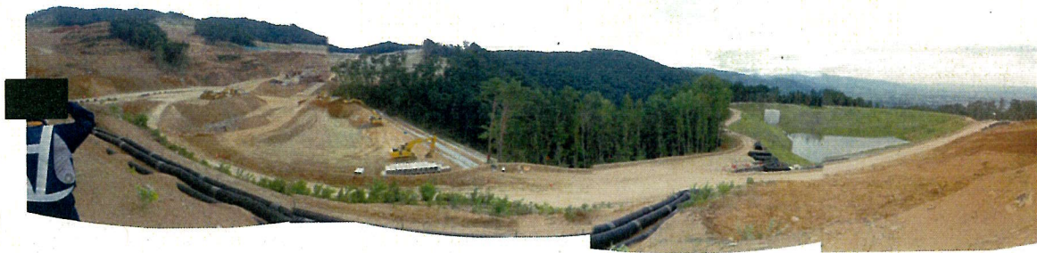
1号調節池上流高盛土および2号調節池 進捗を確認
