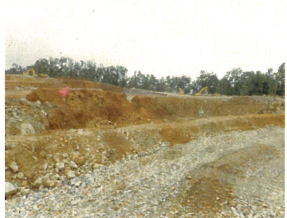
3号調整池上流部 仮沈砂地
