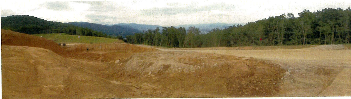
2号調節池側道 マウンド及び沈砂池を確認
