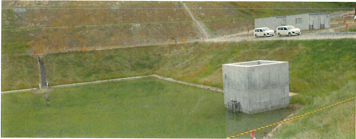
3号調節池 水位オリフィス以下を確認
