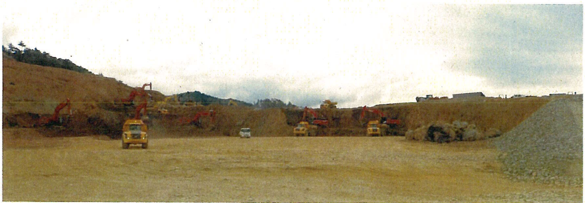
C工区掘削状況 計画地盤まで切り下げる進捗を確認
