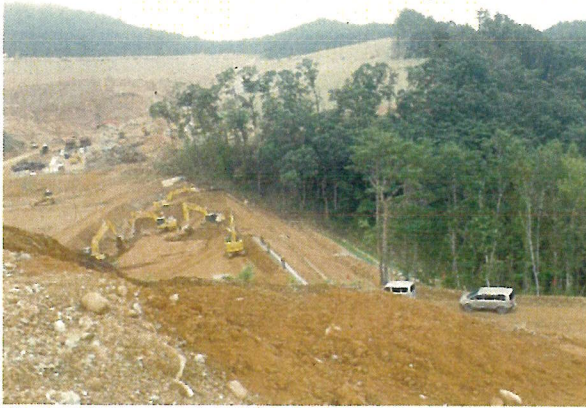
1号調整池上部
