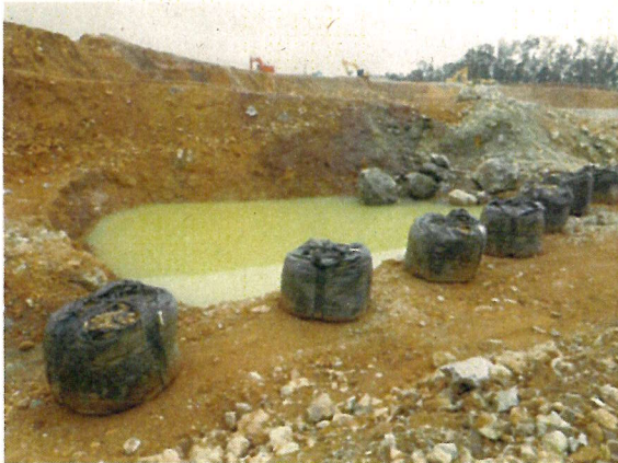
3号調整池上流部 仮沈砂地
