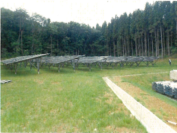
モックアップパネル（緑化状況）
