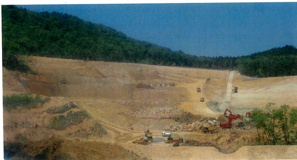
A工区の土工進捗状況
